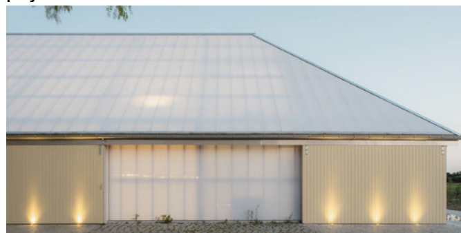
polycarbonate pour la toiture
